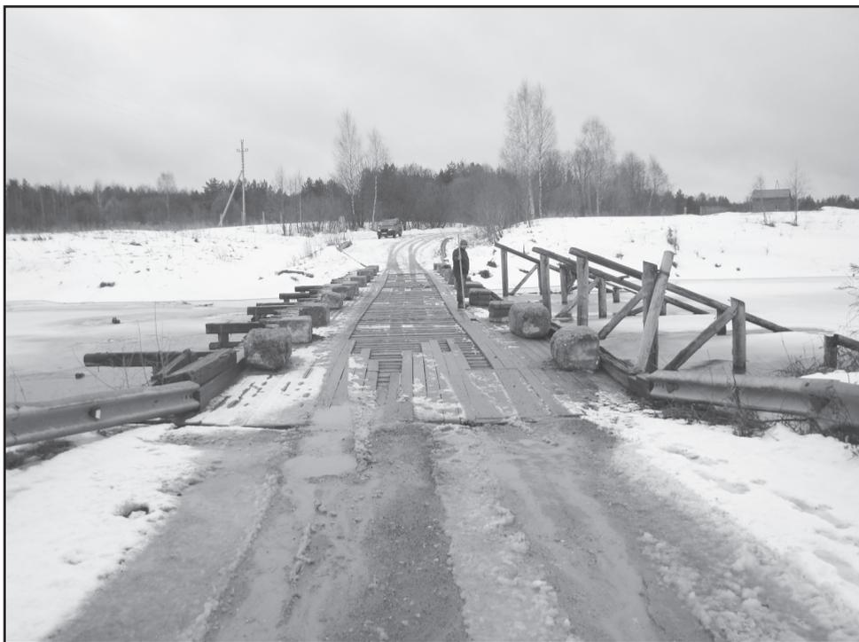
организации демонтировали деревянный настил, установили бетонные блоки по обим краям проезжей части моста. В настоящее время для водителей
